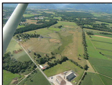
Vue aérienne du CRA de Campistrous
