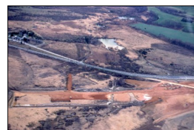
Chantier Autoroute (Capvern - 65)
